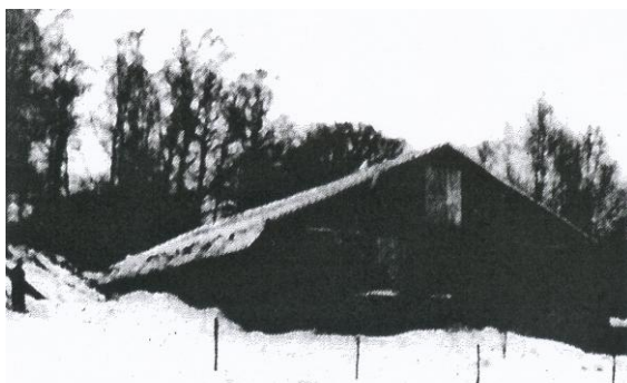
Det stora svinhuset har placerats ovanligt väl i landskapet.
