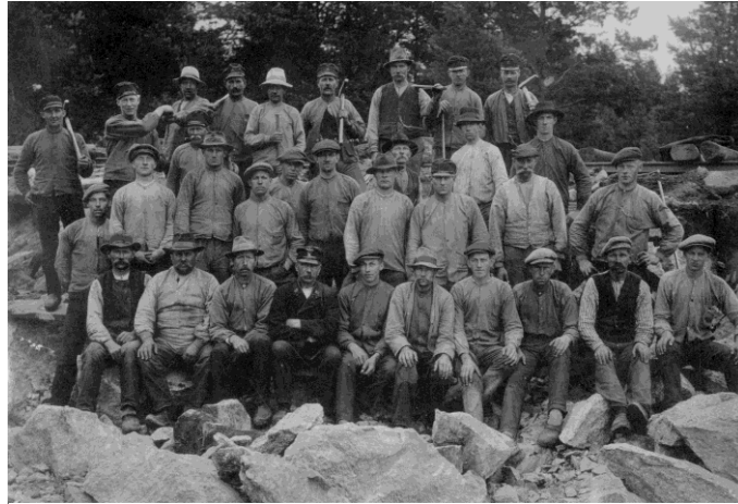
Arbetsstyrkan under Blädinge stations byggande sommaren 1917.
