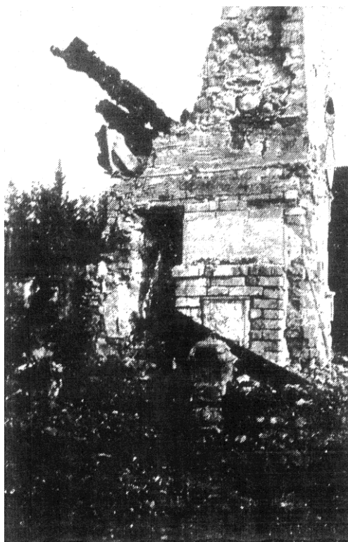
Det var bara skorstensstocken och några förbrända bjälkar kvar av huset, när elden var släckt.
